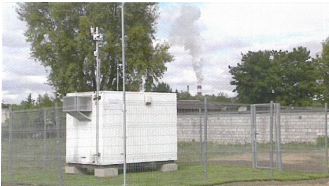
Rysunek 39. Widok stacji pomiarowej i komina PKN ORLEN
