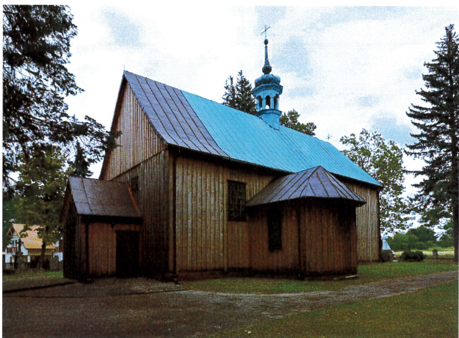
Il. 13. Płock, Trzepowo, Kościół pw. św. Aleksego, fot. M. Horbowicz, 2025
