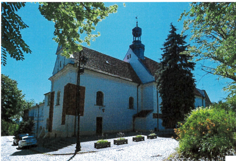
Il. 8. Płock, Kościół pw. św. Dominika, fot. M. Horbowicz, 2025
