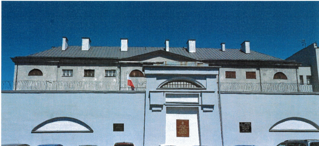
Il. 24. Płock, ul. Sienkiewicza, budynek więzienia, tzw. „stare” więzienie , fot. M. Horbowicz, 2025
