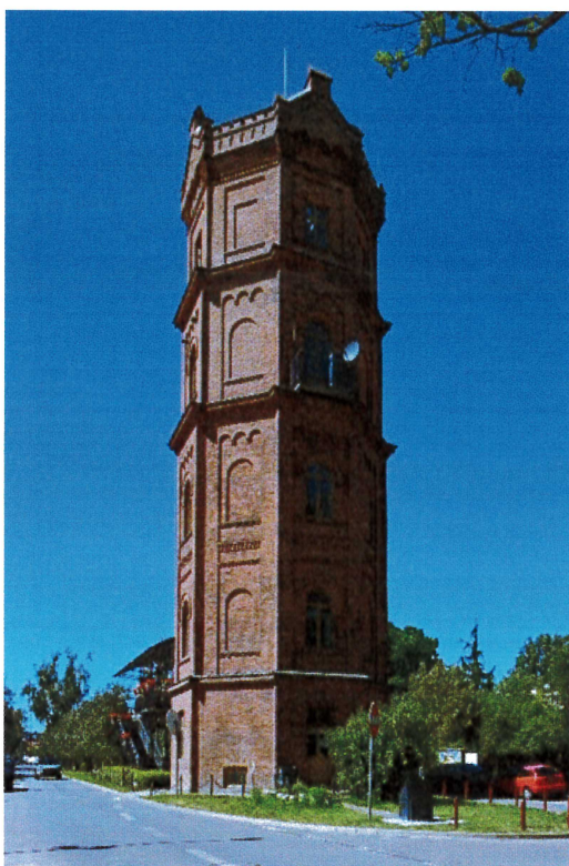
Il. 28. Płock, ul. Warszawska 26, Wieża ciśnień, fot. M. Horbowicz, 2025
